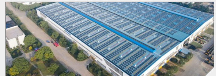
중국법인 4MW급 공장 지붕태양광
